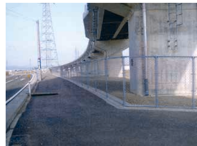
工事名：平成26年度永平寺大野道路標識 その他工事 内 容：立ち入り防止柵フェンスその他 発注者：国土交通省近畿地方整備局福井河川国道事務所 完 成：平成27年3月
