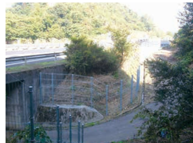
工事名：北陸自動車道福井管内立入防止柵工事 内 容：福井管内立入防止柵工事 発注者：中日本高速道路㈱ 完 成：平成24年12月
