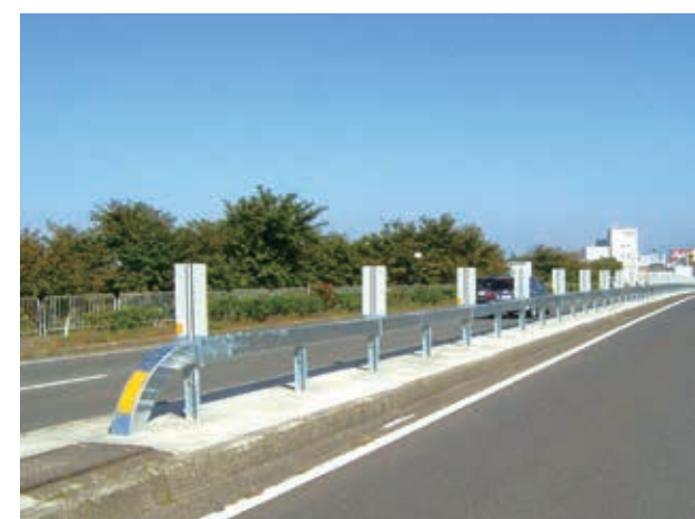
工事名：福井河川国道管内防護柵工事改修工事 内 容：中央分離帯ボックスビーム工事 発注者：国土交通省近畿地方整備局福井河川国道事務所 完 成：平成24年3月
