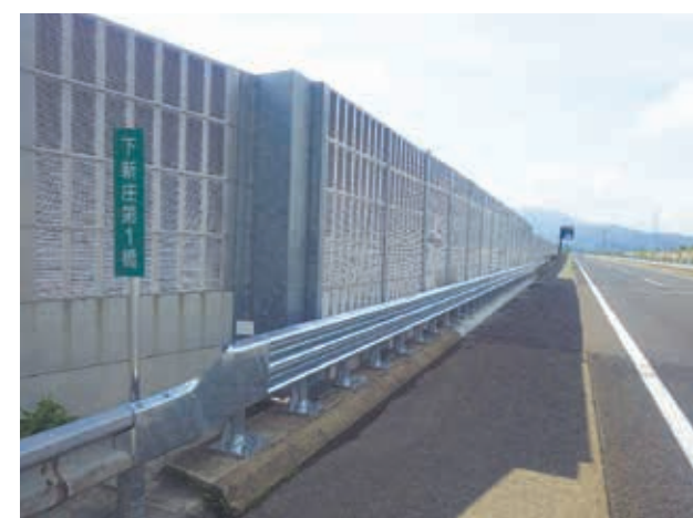
工事名：北陸自動車道今庄IC～加賀IC間防護柵 更新工事 内 容：ガードレール工事 発注者：中日本高速道路㈱ 完 成：平成27年3月
