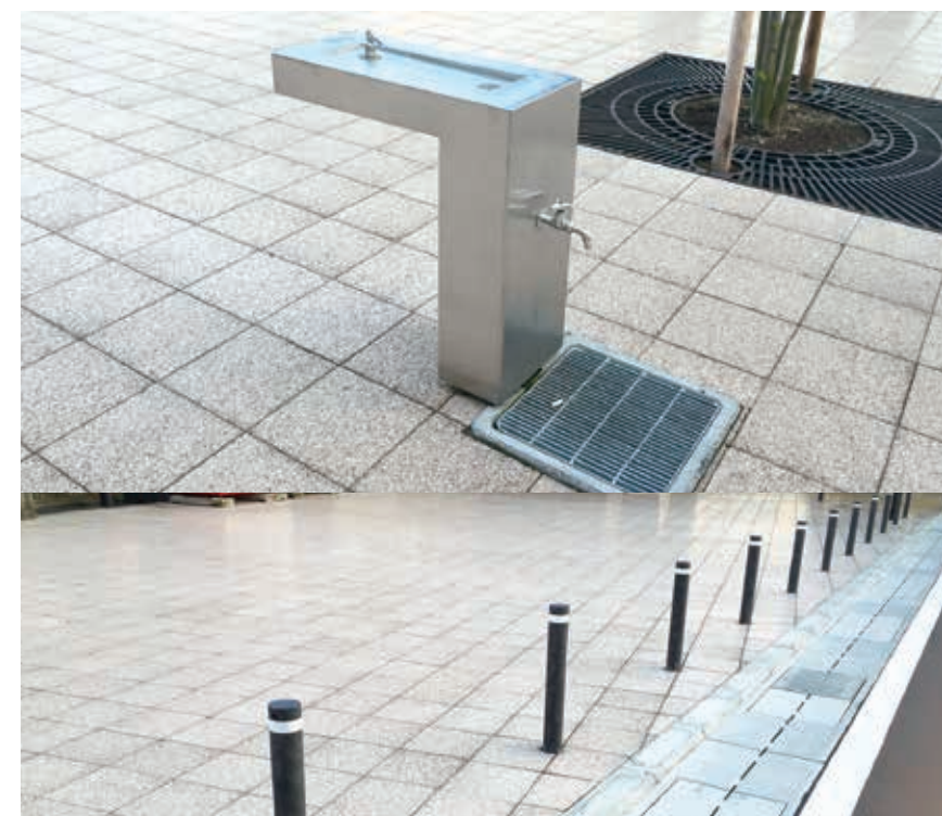
工事名：敦賀駅西地区開発工事 内 容：水飲み場・ 車止めボール設置工事 発注者：敦賀市 完 成：平成26年3月
