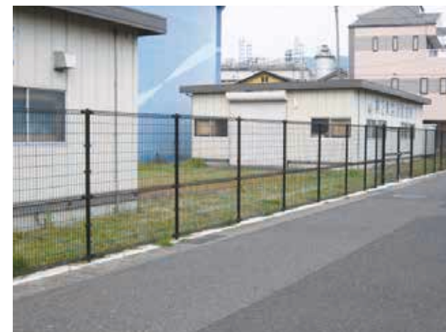
工事名：昭和浄水場フェンス取替修繕 内 容：フェンス取替修繕 発注者：敦賀市役所 完 成：平成27年7月
