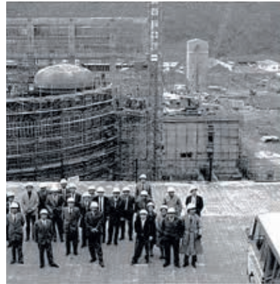
建設中の原子力発電所見学のコマ(昭和45年頃)
