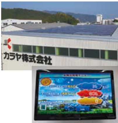
木崎営業所第2倉庫屋根に設置 パネル面積323.76㎡、 パネル枚数198枚(1枚:1650mm×991mm)、 発電出力46.5kw
