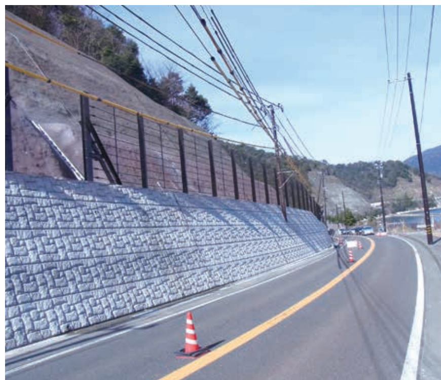
工事名：原子力制圧道路等 整備工事 内 容：敦賀市二村地係 落石防護柵工 発注者：福井県敦賀土木事務所 完 成：平成26年度
