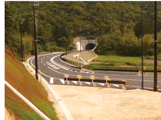
工事名：市道西浦1号線道路整備工事その2 内 容：防護柵工700m他安全対策工 発注者：敦賀市 完 成：平成27年5月
