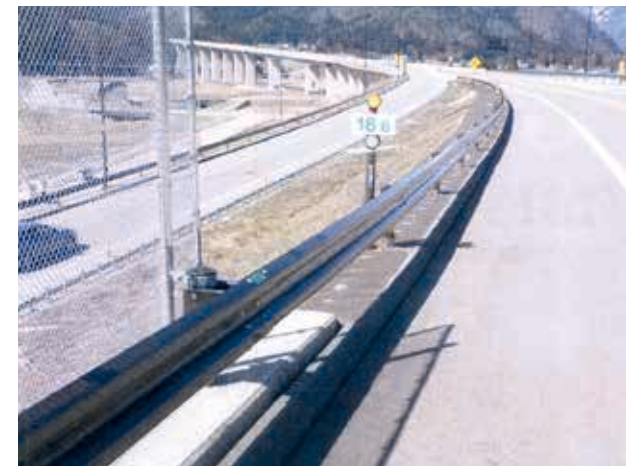
工事名：平成24年度永平寺大野道路標識 その他工事 内 容：ガードレールその他 発注者：国土交通省近畿地方整備局福井河川国道事務所 完 成：平成25年3月
