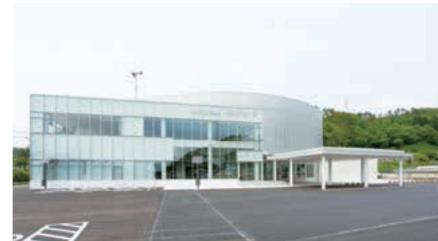
工事名：長山公園屋内運動施設ゾーン 体育館新築工事 内 容：H・L・Cカラー QL、TBB、SPL、 STK490B丸パイプ、朝日スチールフェンス 発注者：勝山市 完 成：平成28年4月
