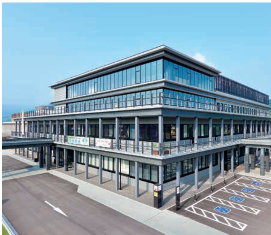
工事名：大野市庁舎整備事業 工事その1 内 容：(その1)鉄筋、型枠、 屋根及び樋、金属工事 仕上げユニット工事 外構工事 (その2)ルーフトレン、 サイン工事、金属工事、鉄筋 発注者：大野市役所 完 成：平成26年11月 写真提供元：大野市役所
