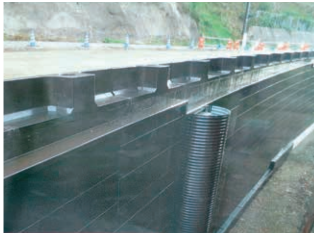
工事名：三方～世久見道路改良工事 内 容：道路拡幅工事 発注者：国土交通省近畿地方整備局福井河川国道事務所 完 成：平成25年11月
