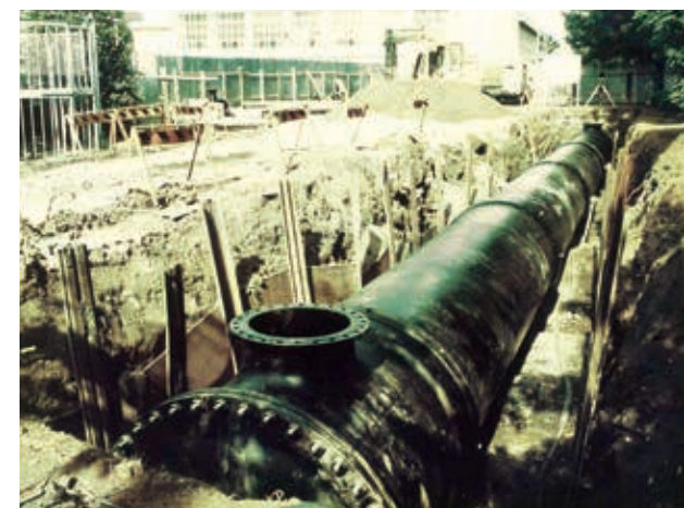
工事名：小学校非常用貯水装置敷設工事 (順化小学校他) 内 容：非常用貯水装置敷設工事 発注者：福井市 完 成：昭和57年(第1回敷設・順化小学校)
