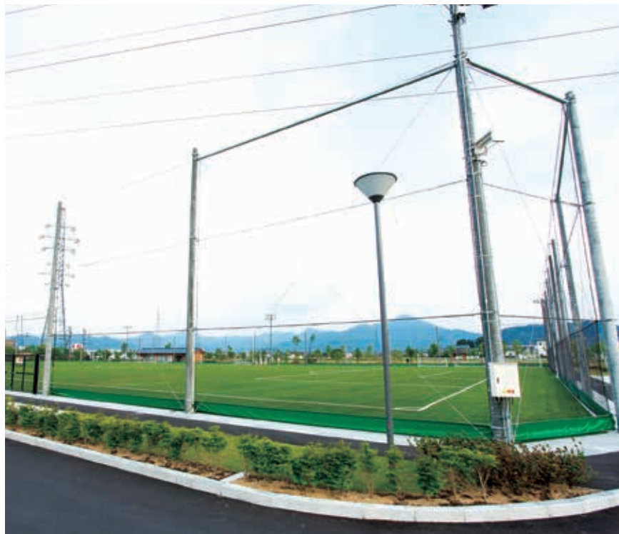
工事名：越前市新サッカー場 内 容：フェンス外構工事 発注者：越前市 完 成：平成28年4月
