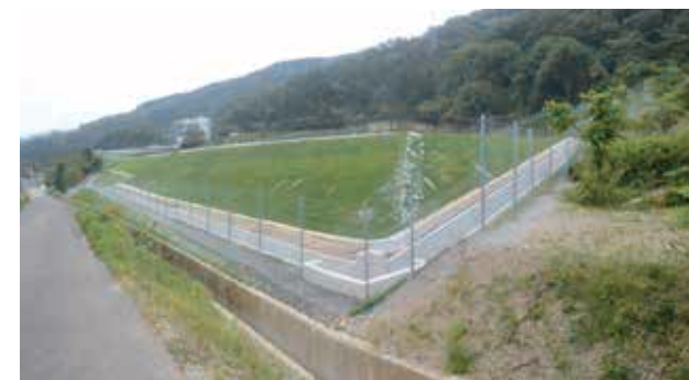
工事名：グラウンド・ゴルフ場（リラグリーン） 造成工事 内 容：獣害防止柵工 H=2100 延長1000m 発注者：敦賀市 完 成：平成27年5月
