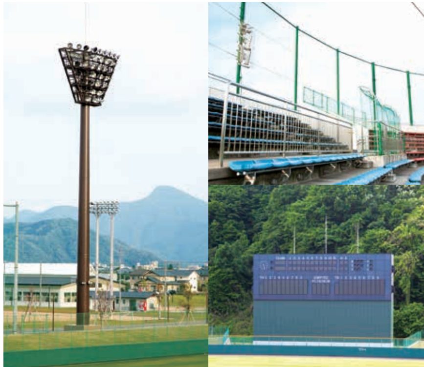
工事名：丹南総合公園 内 容：野球場ナイター設備・フェンス・ 防球ネット設置工事 発注者：福井県丹南土木事務所 完 成：平成25年9月
