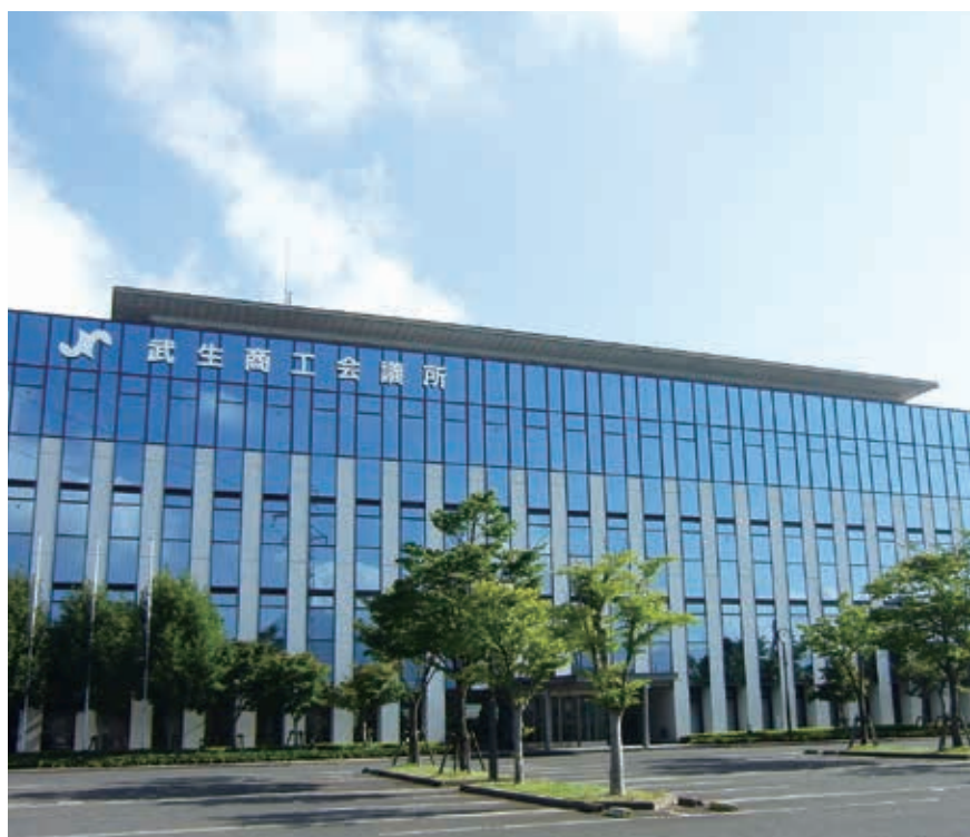
工事名：武生商工会議所 新築工事 内 容：資材納入 発注者：武生商工会議所 完 成：平成9年 写真提供元：武生商工会議所
