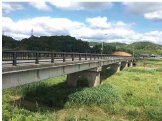
工事名：清水山橋橋梁補修工事 （防災・安全交付金〔補正予算〕） 内 容：橋梁補修工事 発注者：福井県福井土木事務所 完 成：平成27年3月
